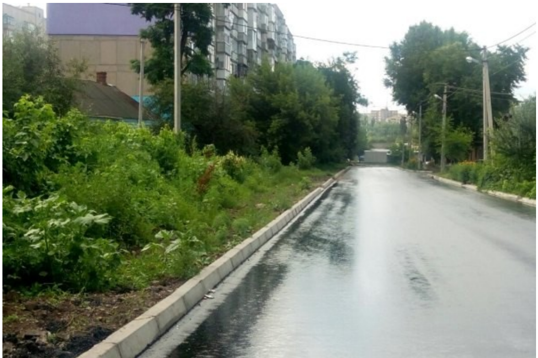
Вул. Андріївська після ремонту.
