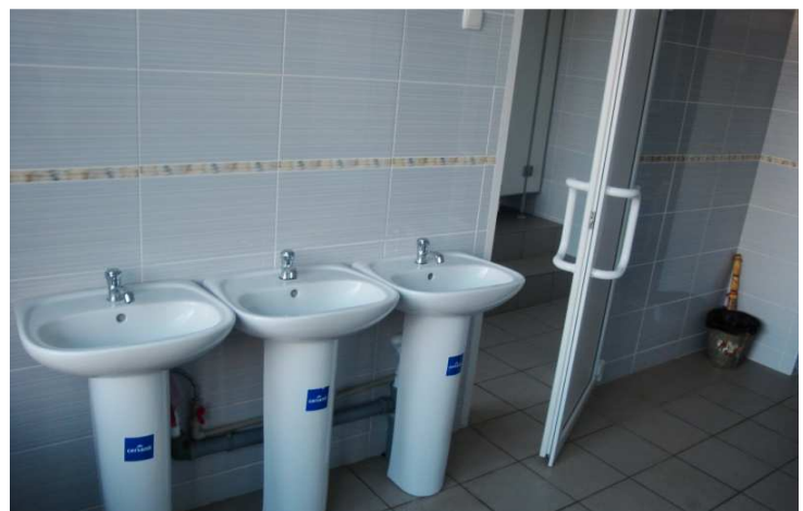
Відремонтовані санвузли ЗОШ № 13
