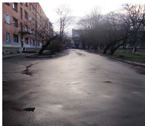
Прибудинкова дорога по вул. Євгенія Тельнова 2, корп. 2
